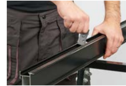
2. Byg hjælpekonstruktionens ramme med hjørnebeslag
